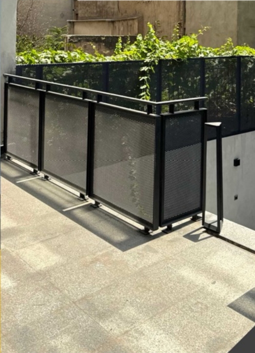
ساختمان مرکزی شرکت آبنوس تهران - خیابان طالقانی
